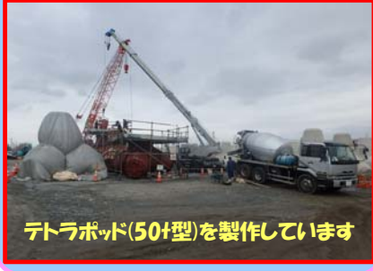
8Lot(最終層)のコンクリート打設が完了しました。
