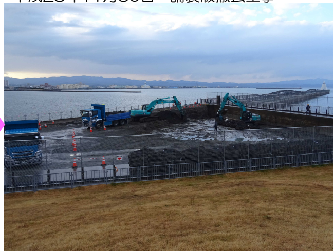
平成28年11月30日 舗装版撤去工事
