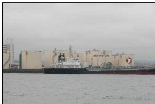
青森港沖館地区 東西オイルターミナル(株)
