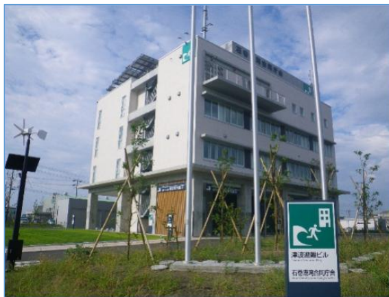
【津波避難ビルに指定された庁舎：石巻】
