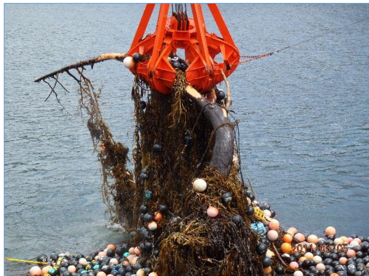
【流木等の引揚げ作業】
