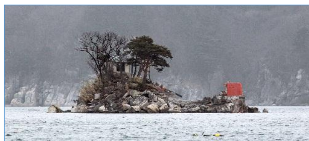
【倒壊した大槌港灯台：釜石海上保安部】
