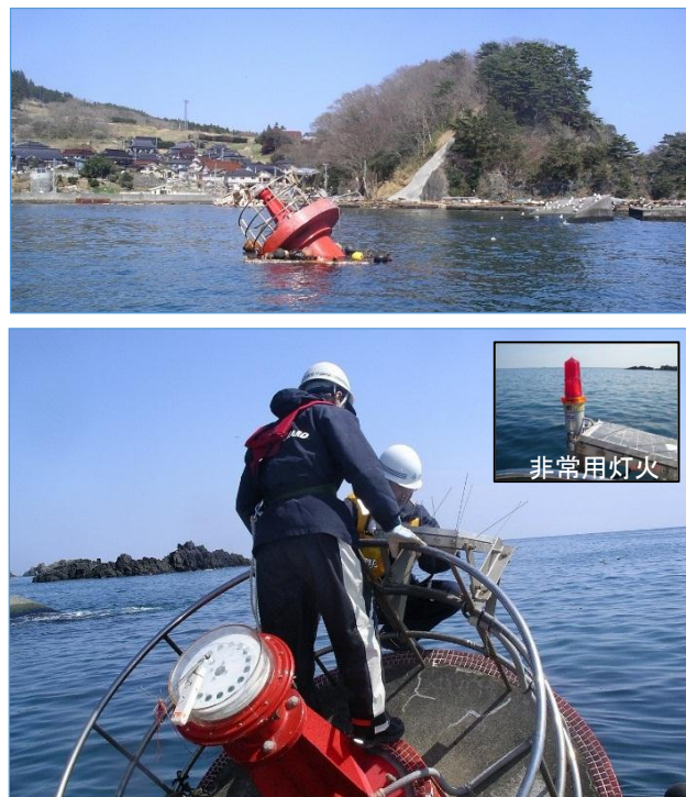
【応急復旧作業の状況：大船渡港】
