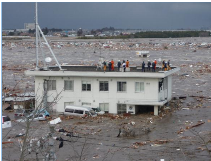
【津波により浸水した庁舎：仙台航空基地】
