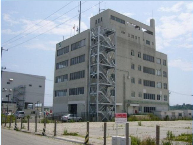
【復旧した気仙沼合同庁舎：気仙沼海上保安署】
