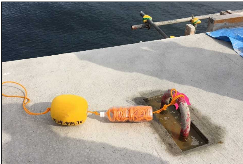
防波堤工事の作業現場に設置した非常投浮（実物）
