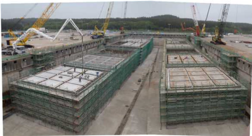
▲ケーソン製作状況（2012年6月6日撮影）
