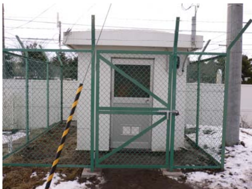
観測施設復旧（既設）
