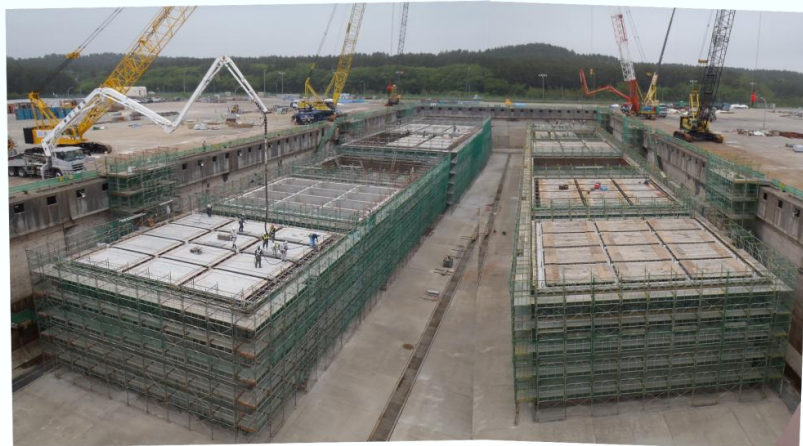
むつ小川原港ケーソンヤードにて製作中のケーソン
