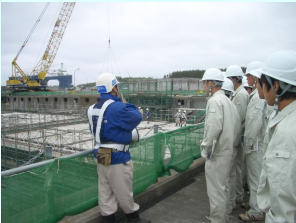
工事担当より概要説明
