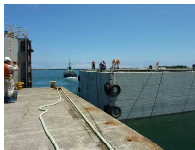
ケーソン引出し
