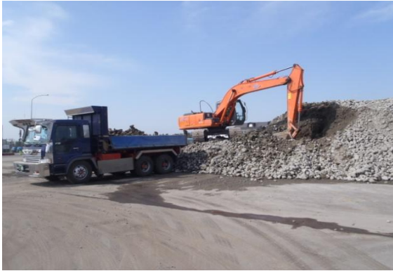
[コンクリート殻積込状況]
