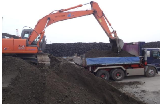
[撤去砂積込状況]
