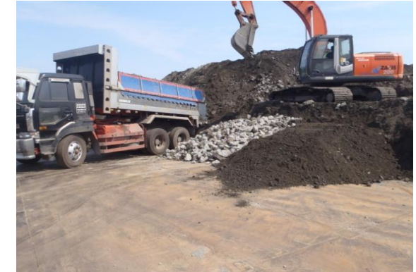
[撤去砂とコン殻運搬状況]
