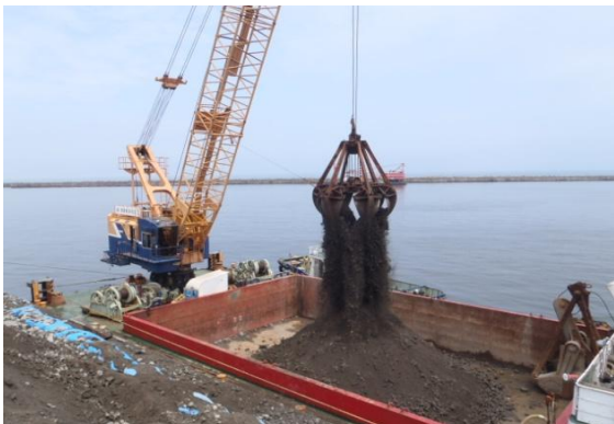
[撤去砂とコン殻混合後の積込状況]
