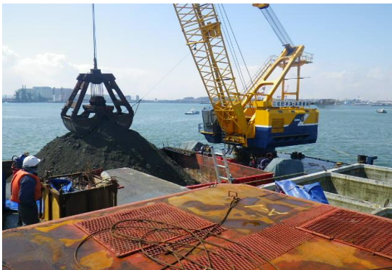
[撤去砂とコン殻混合後の投入状況]
