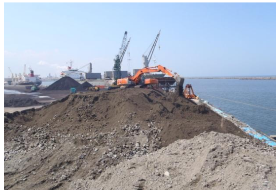
[撤去砂とコン殻混合状況]
