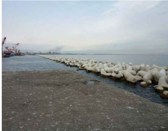
復旧状況（平成 23 年 12 月 22 日時点）
