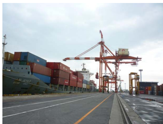
荷役状況（平成23年9月30日時点）
