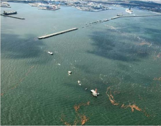
被災状況（平成 23 年 3 月 12 日時点）
