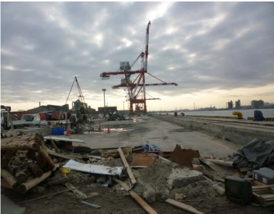
被災状況（平成 23 年 4 月 18 日時点）
