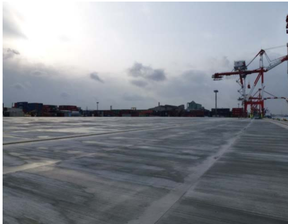
復旧状況（平成 23 年 12 月 16 日時点）
