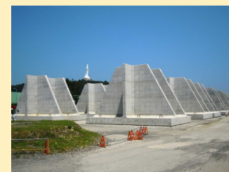
製作状況(釜石港)
