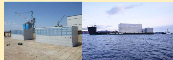
HBケーソン完成形
