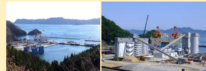
泉作業基地全景
