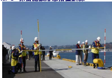
東北地方整備局職員及び防災エキスパートによる係留施設点検
