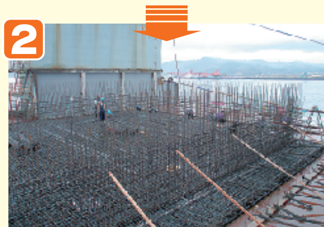
●鉄筋組立作業
