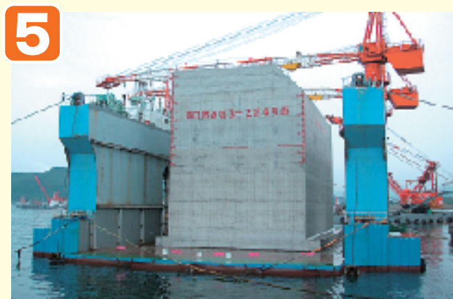
●ケーソン完成
