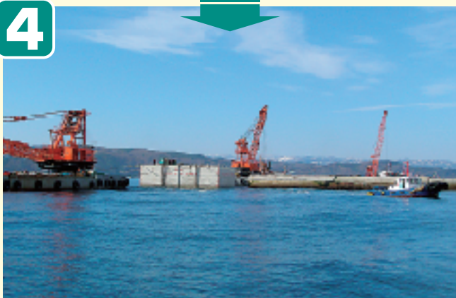
●ケーソン据付
