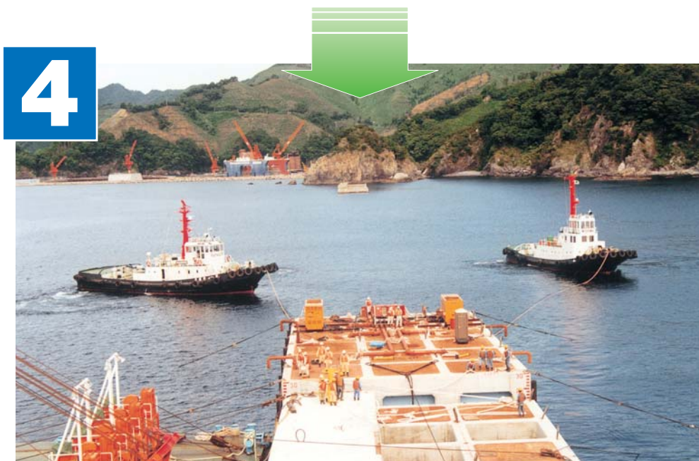
◆据付位置決め・注水
