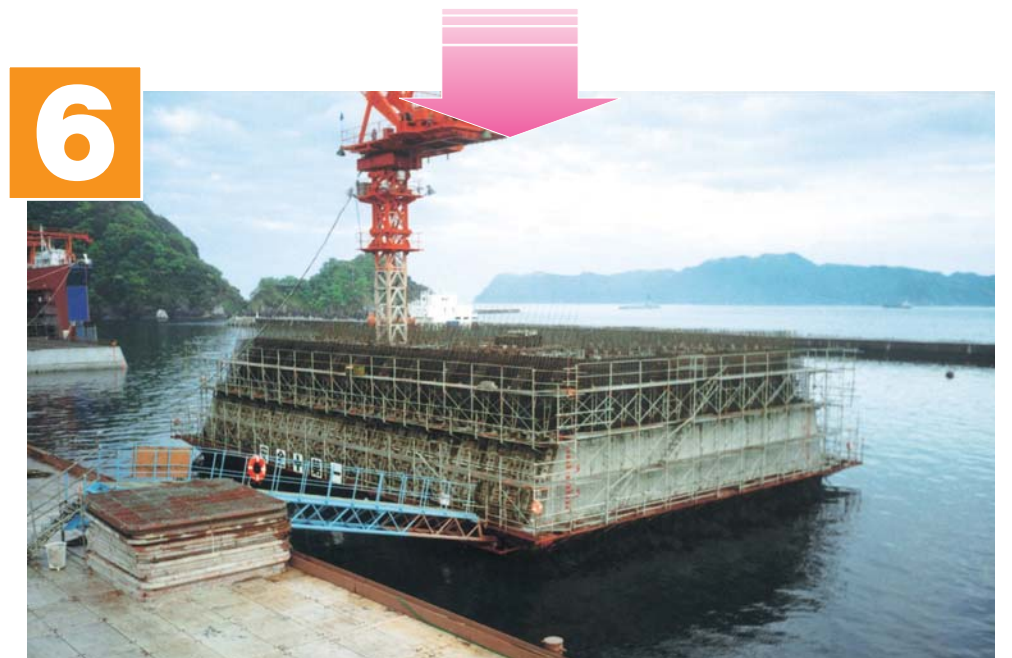
◆海上打継型枠組立
