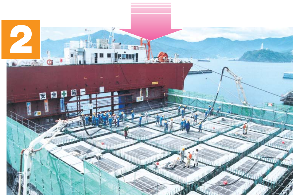
◆コンクリート打設 (FD 1~4段目)
