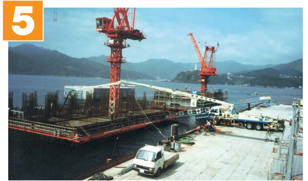
◆海上打継コンクリート打設 (5~12段目)
