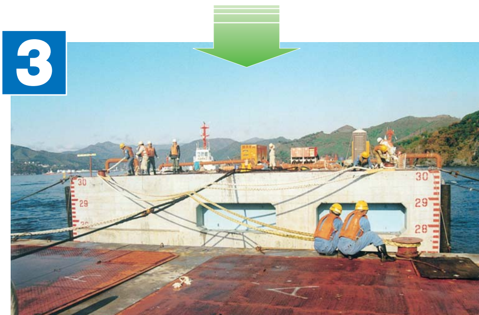
◆据付開始(ワイヤーリング作業)
