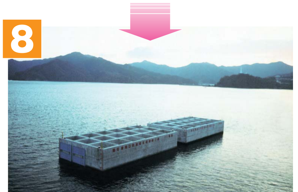
◆ケーソン製作完了 (最終仮置場)
