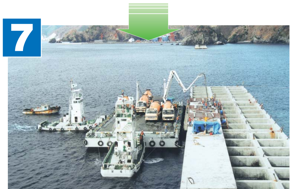
◆上部コンクリート打設(暫定)
