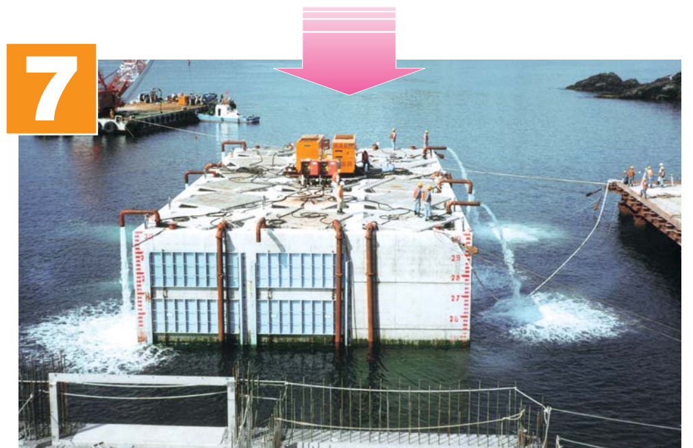
◆海上打継完了・浮上・移動・仮置
