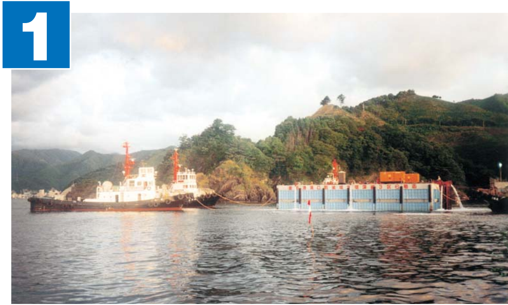
◆ケーソン内排水・浮上(最終仮置場)
