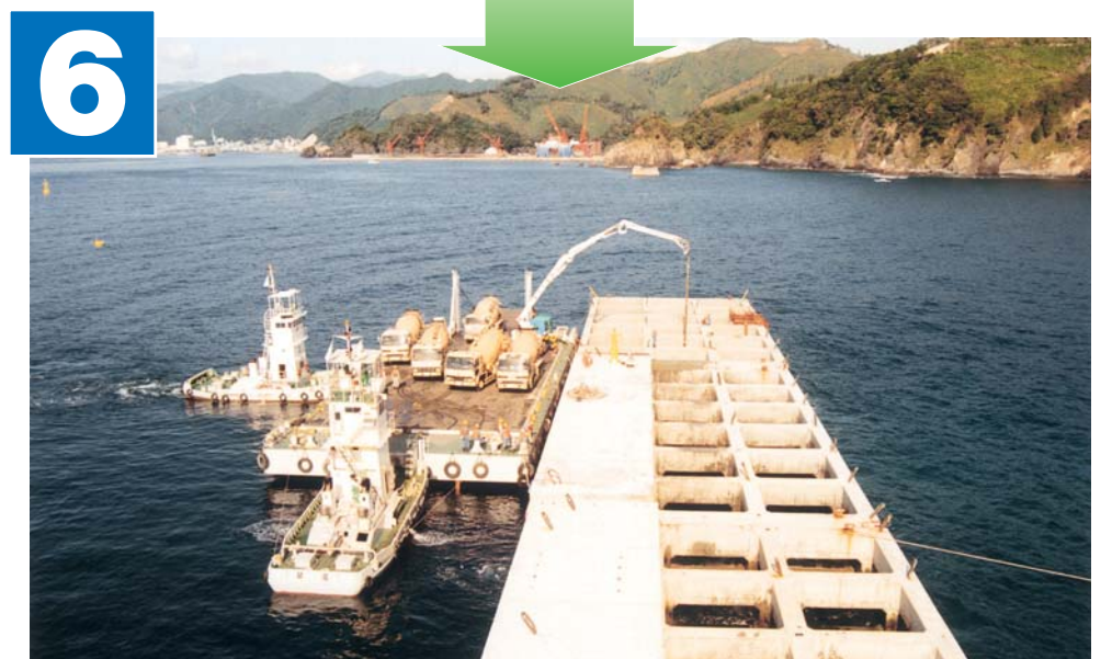
◆蓋コンクリート打設
