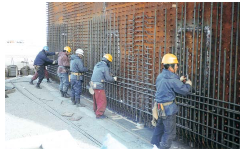
②鉄筋組み立て作業
