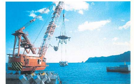
被覆ブロック梱包据付作業
