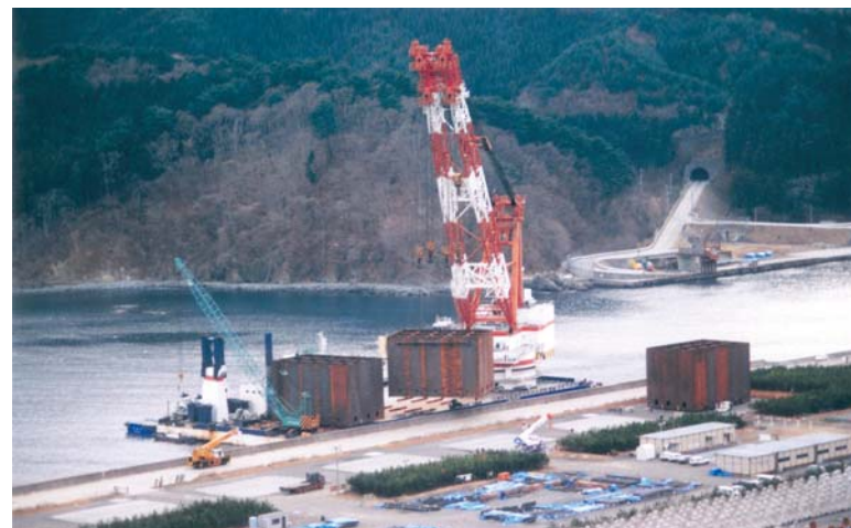
①工場製作された、鋼鉄性ケーソンの陸揚げ作業
