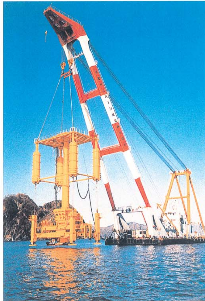
起重機船により作業場所まで運ばれる捨石均し機
