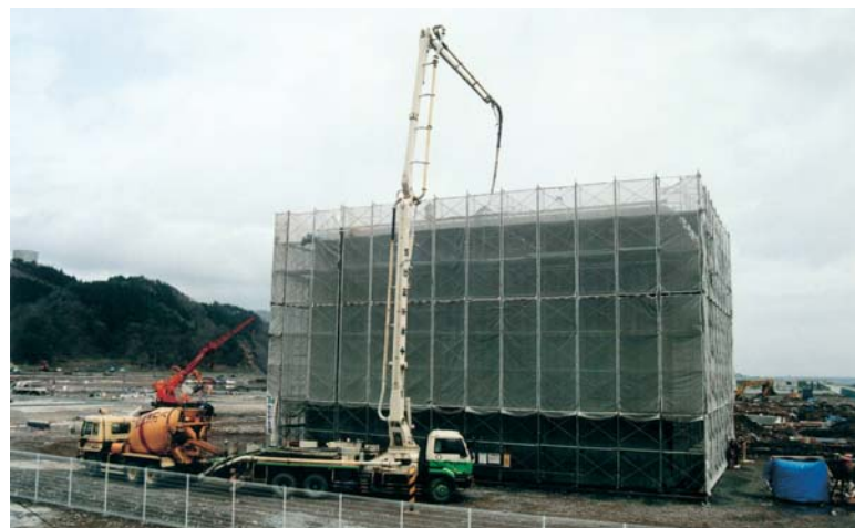
④コンクリートポンプ車による打設作業
