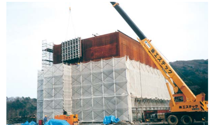
③型枠組み立て作業
