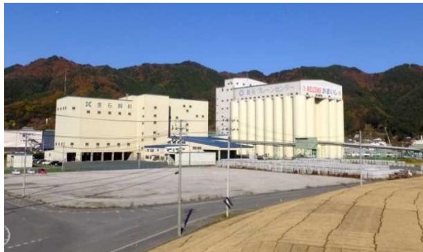
▲釜石グレンセンターサイロ(右) 釜石飼料工場(左)
