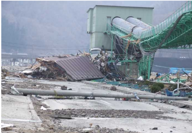
▲被災したベルトコンベア
