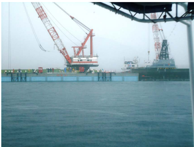
▲ケーソン据付状況②
