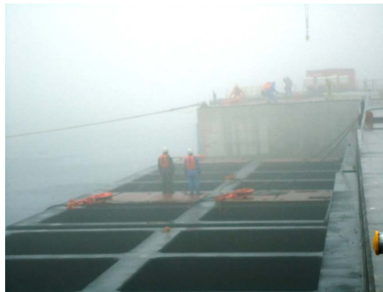
▲ケーソン据付状況①
