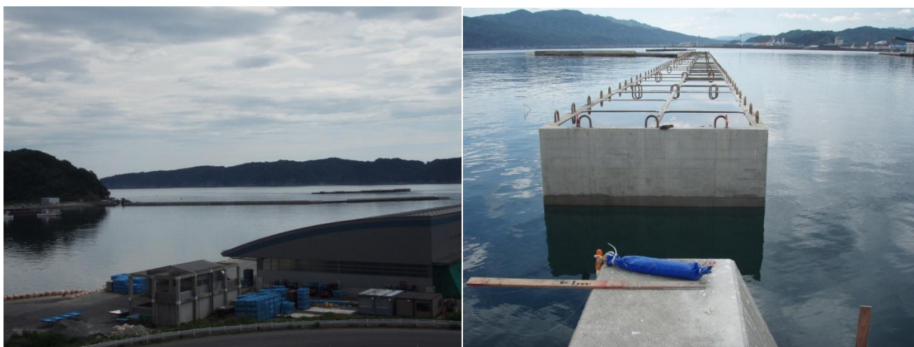
据付が完了した出崎防波堤
