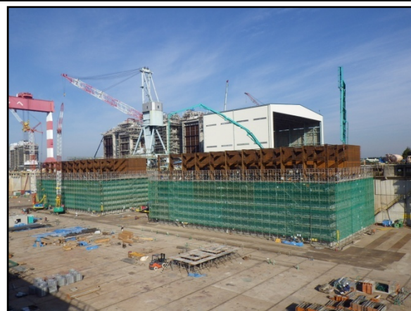
コンクリート打設
