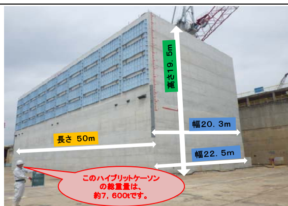
ハイブリッドケーソン完成
