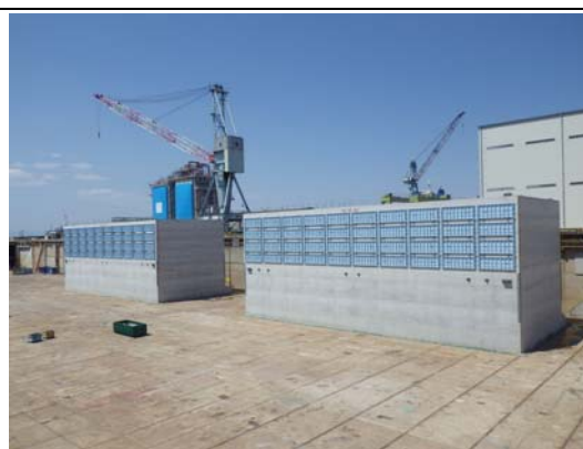
ハイブリッドケーソン完成(全景)
