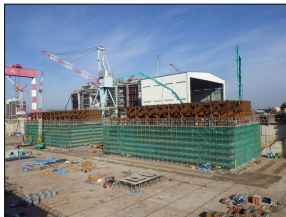
コンクリート打設
