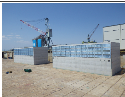
ハイブリッドケーソン完成（全景）
