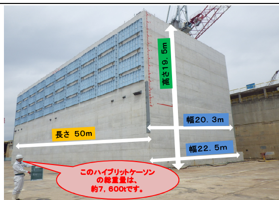
ハイブリッドケーソン完成
