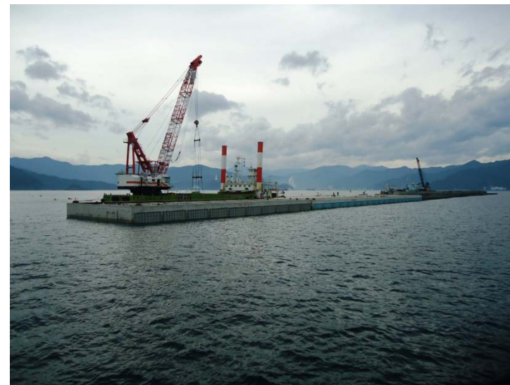
▲当日の作業状況(ケーソン中詰)
