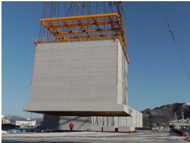
▲ ケーソン吊上げ状況①
