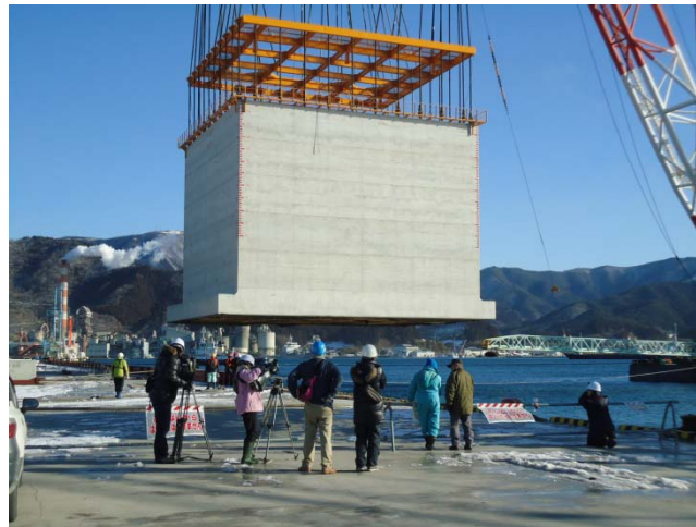
▲ ケーソン吊上げ状況②
