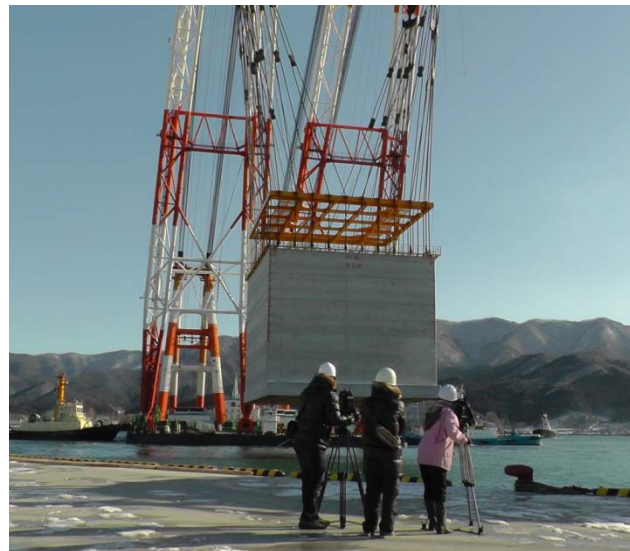
▲ ケーソン吊上げ状況④
