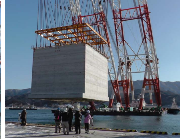
▲ ケーソン吊上げ状況③
