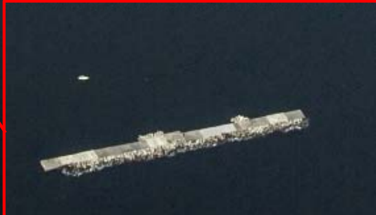
湾口防波堤(北堤)復旧済
