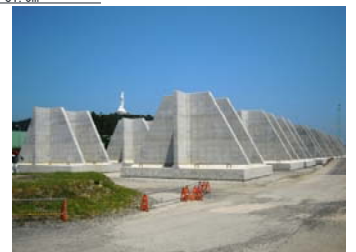
逆T型ブロック仮置状況 (住所：釜石市平田第3地割)
