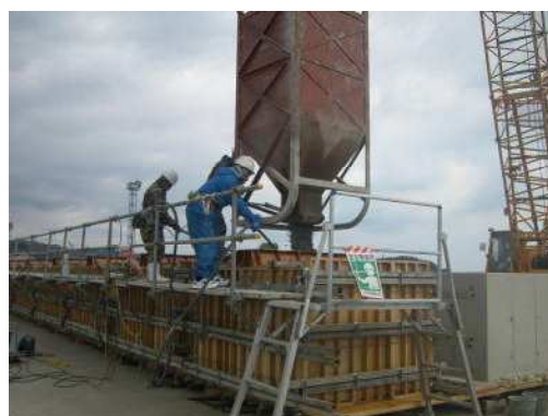
コンクリート打設状況
