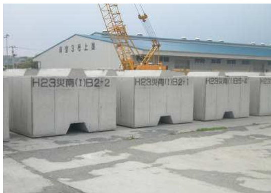
製作する本体ブロック
