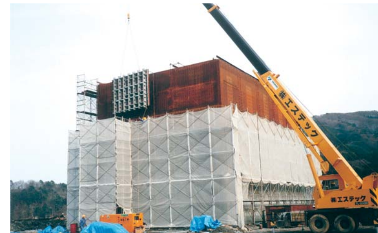
③型枠組み立て作業
