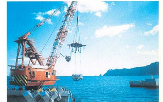
被覆ブロック梱包据付作業
