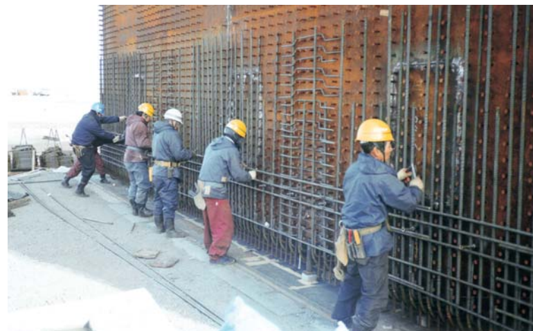
②鉄筋組み立て作業
