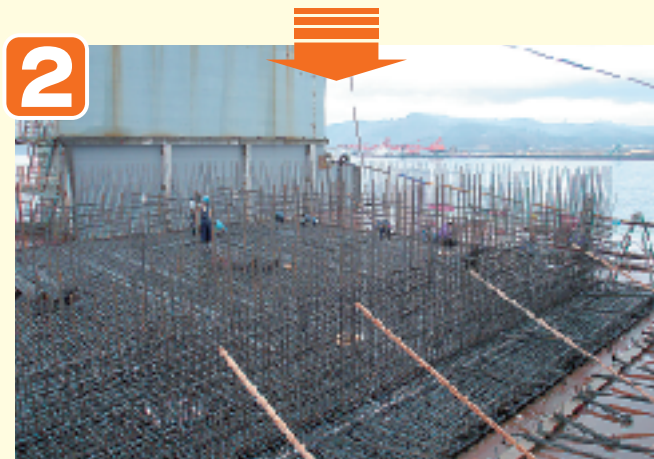
●鉄筋組立作業
