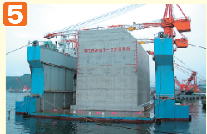
●ケーソン完成
