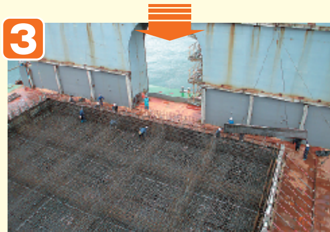
●型枠組立作業
