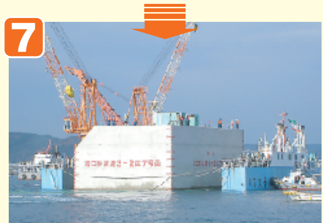
●ケーソン進水
