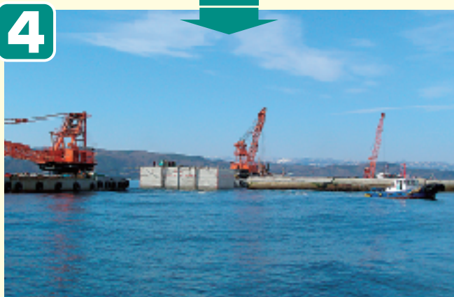
●ケーソン据付
