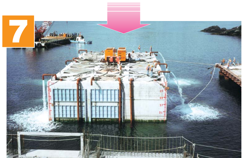
◆海上打継完了・浮上・移動・仮置
