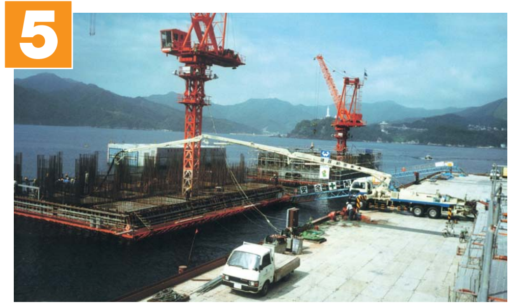
◆海上打継コンクリート打設 (5~12段目)
