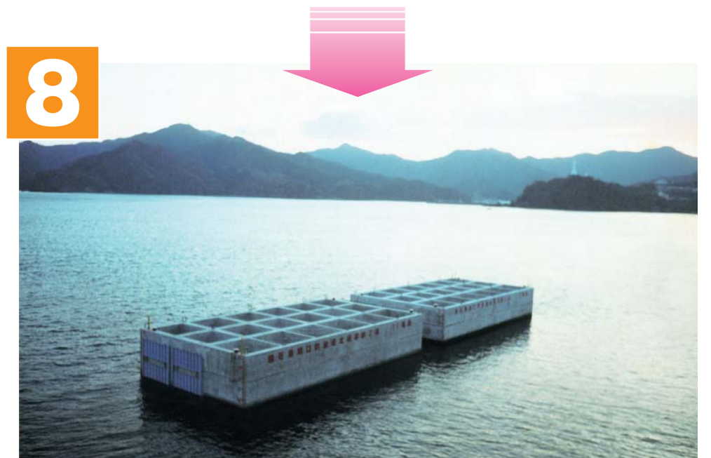
◆ケーソン製作完了 (最終仮置場)
