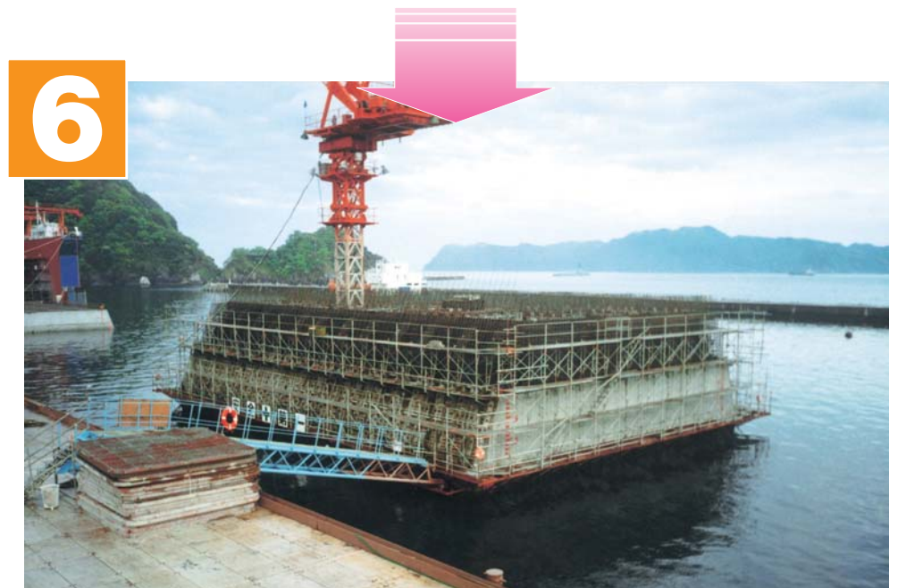
◆海上打継型枠組立
