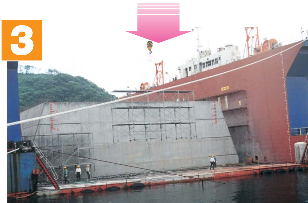
◆FDでの製作完了・進水準備
