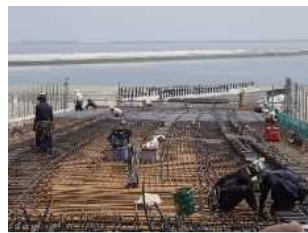
②鉄筋・シース組立
