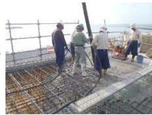
③コンクリート打設
