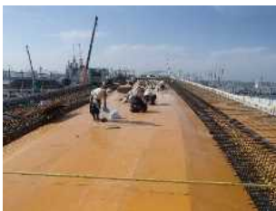
①型枠組立
