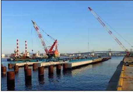
工事場所(全景)
