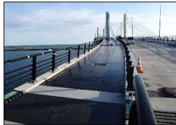
塗布作業後状況(全景)
