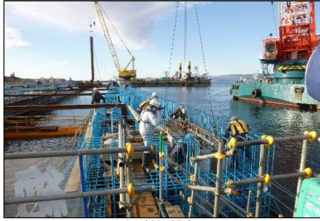
受梁鉄筋組立て
