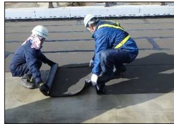
シート敷設作業状況
