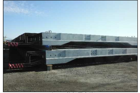
PCホロー桁仮置き状況
