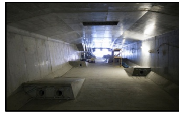
点検は桁内部でも行われ、大規模地震時には健全性を早急に確認する必要があります。
