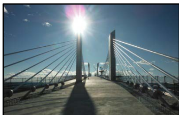
塔から張られているケーブルで橋桁を支えています。ケーブルの健全度の確認も重要です。
