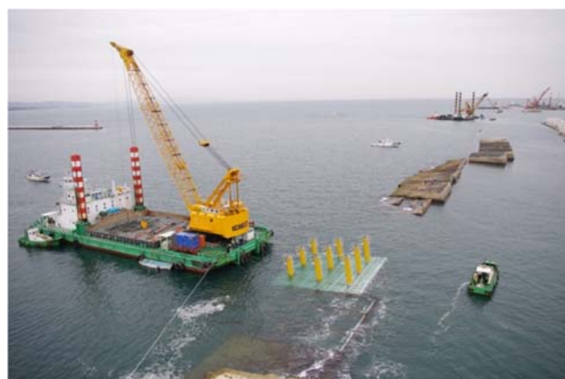
▲ケーソン再浮上工事の様子
