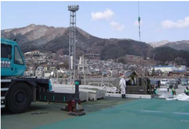
防災フロートからドラム缶を荷揚げ
