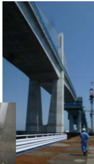
※鉄筋は全てエポキシ樹脂塗装鉄筋を使用 (塩害対策)
