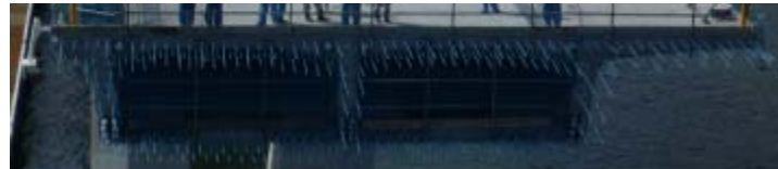
※鉄筋は全てエポキシ樹脂塗装鉄筋を使用 (塩害対策)
