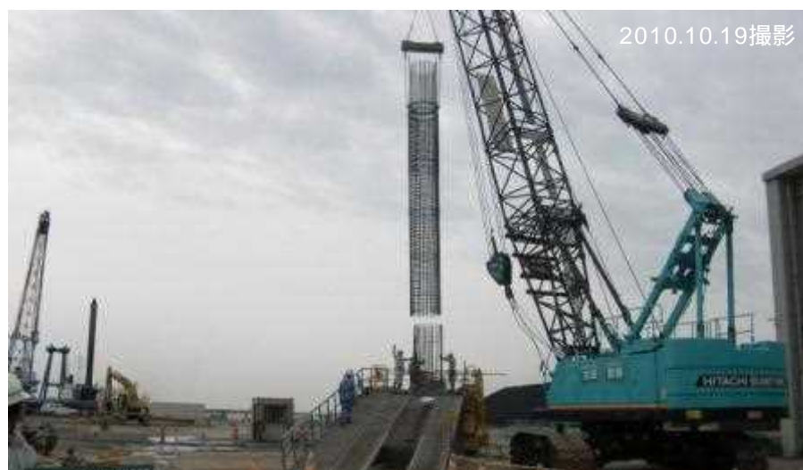
3号ふ頭部 基礎工 場所打ちコンクリート杭
