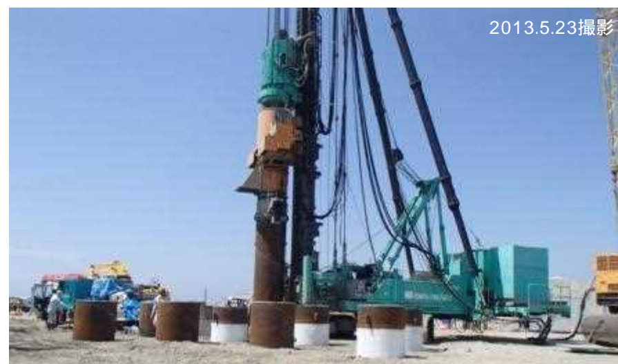
東港部 基礎工 鋼管杭
