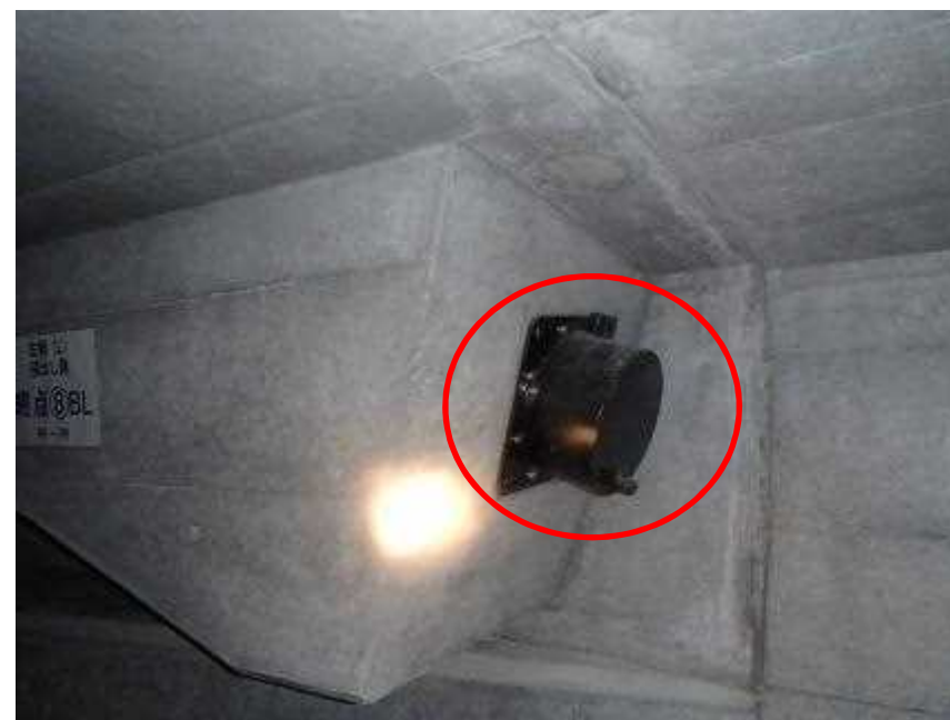
斜材定着部を箱桁内に収納(本橋)
