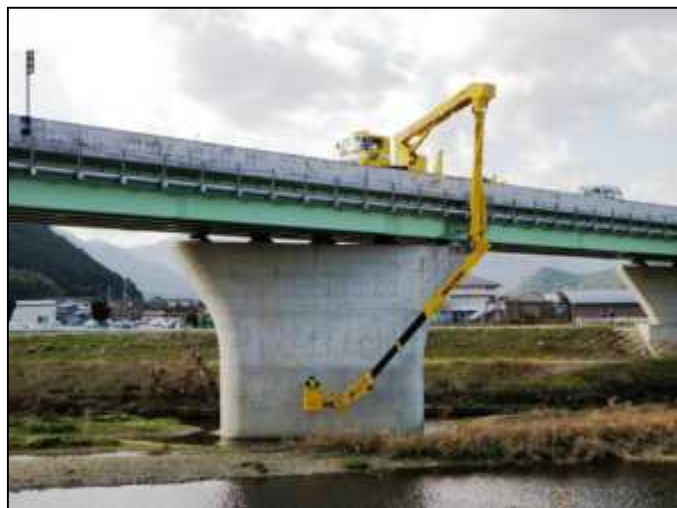
桁下の点検状況
