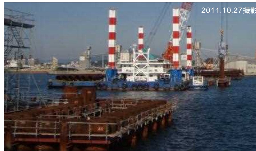
航路部P7、P8 基礎工 鋼管井筒矢板基礎
