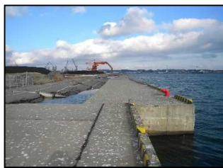
5・6号ふ頭先端護岸
