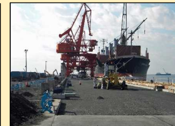
荷役作業の隣で進む復旧工事
