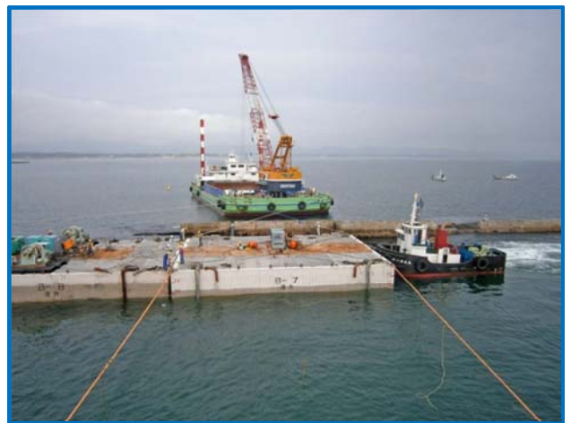
▲ケーソン据付
