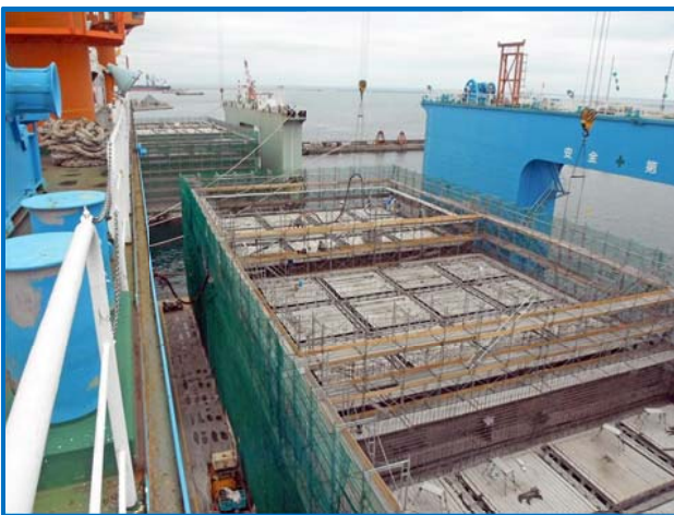
▲製作台船(フローティングドック)でのケーソン製作
