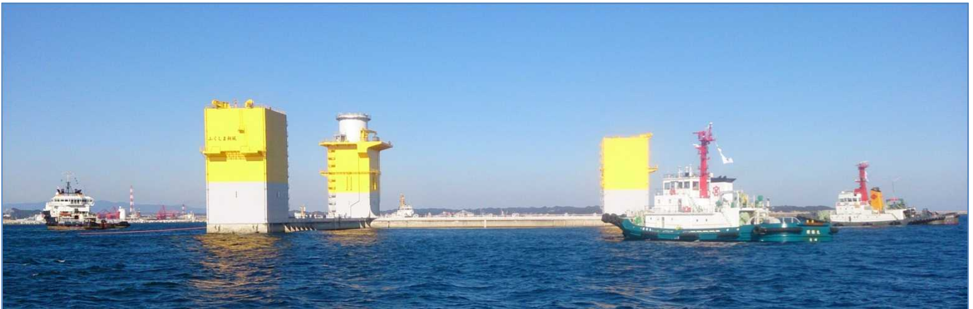
▲小名浜港に到着した7MW級風力発電設備「ふくしま新風」の浮体【画像提供/福島洋上風力コンソーシアム】
