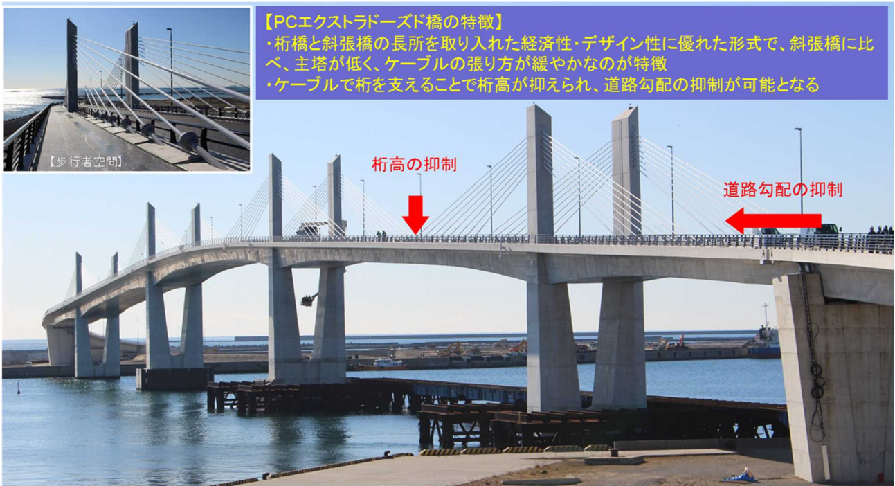
図-1 小名浜マリブリッジ(PC エクストラードズド橋)の特徴
