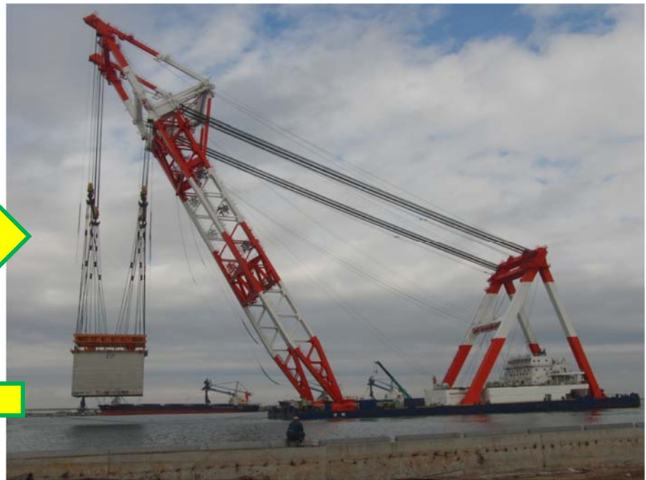
▲ケーソンを陸上から海上へ運ぶ様子
