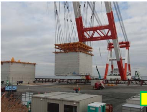
▲ケーソン吊り上げ
