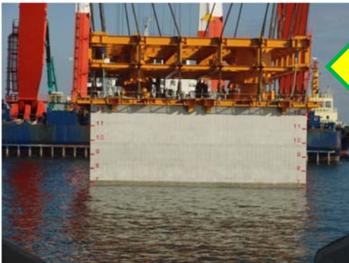
▲ケーソン進水（仮置場へ移設）
