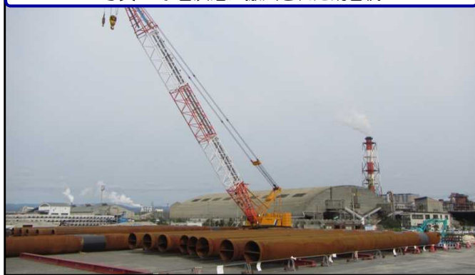
写真 小名浜港に搬入された鋼管杭
