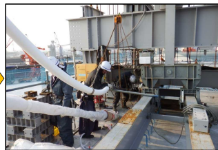
②斜材挿入(桁側)
