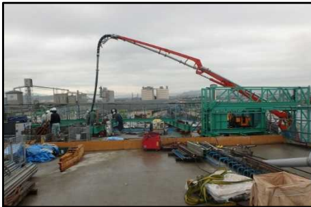
コンクリート打設状況(上床版)
