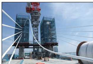
①斜材挿入(主塔側)
