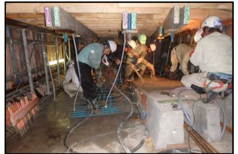
コンクリート打設状況(下床版)
