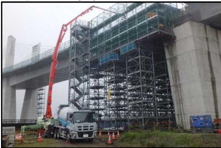
コンクリート打設状況(全景)
