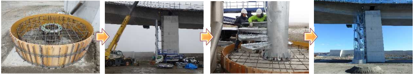
①支柱基礎設置（型枠・鉄筋組立）
