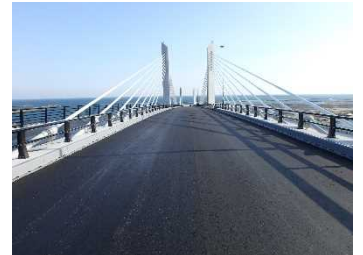
基層完成状況（表層施工前）
