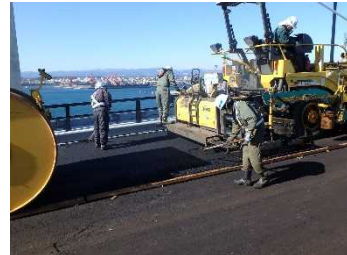
基層敷均し状況
