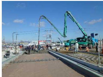
コンクリート打設状況
