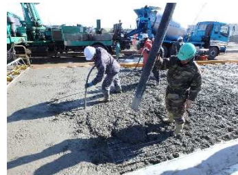
コンクリート打設状況
