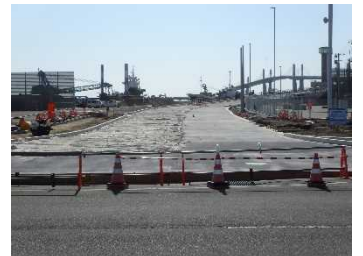
完成状況（左側養生中）
