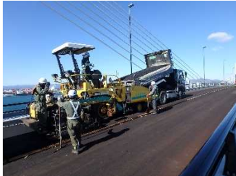
基層敷均し状況
