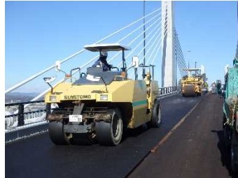
基層転圧状況
