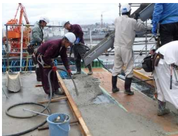
後打ちコンクリート打ち込み
