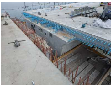
伸縮装置設置前
