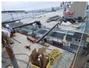
伸縮装置設置後
