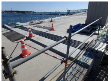
伸縮装置工完成
