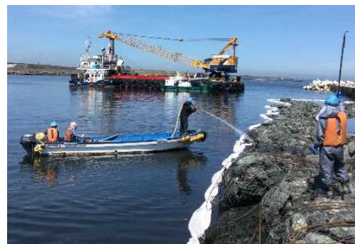
▲埋浚 護岸に付着した油の回収作業
